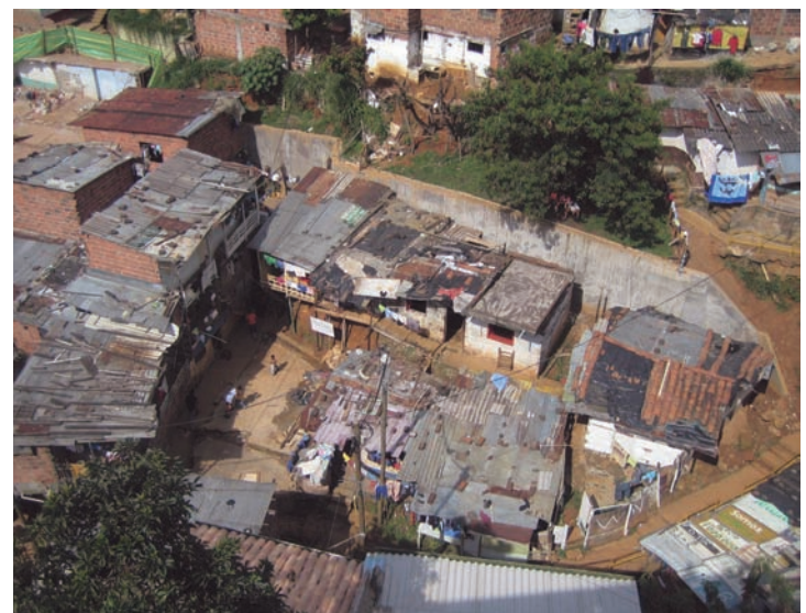
Situación previa. Viviendas en alto riesgo. Sector de Juan Bobo.
