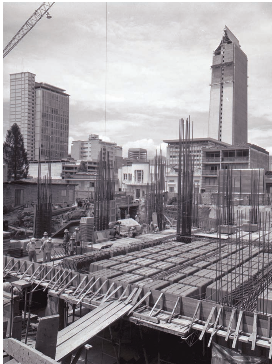
Comienzo años setenta. Construcción del edificio Cámara de Comercio; al fondo el Edificio Coltejer.
