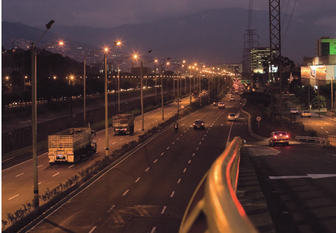
Reordenamiento y ampliación de la avenida Regional paralela al río Medellín.
