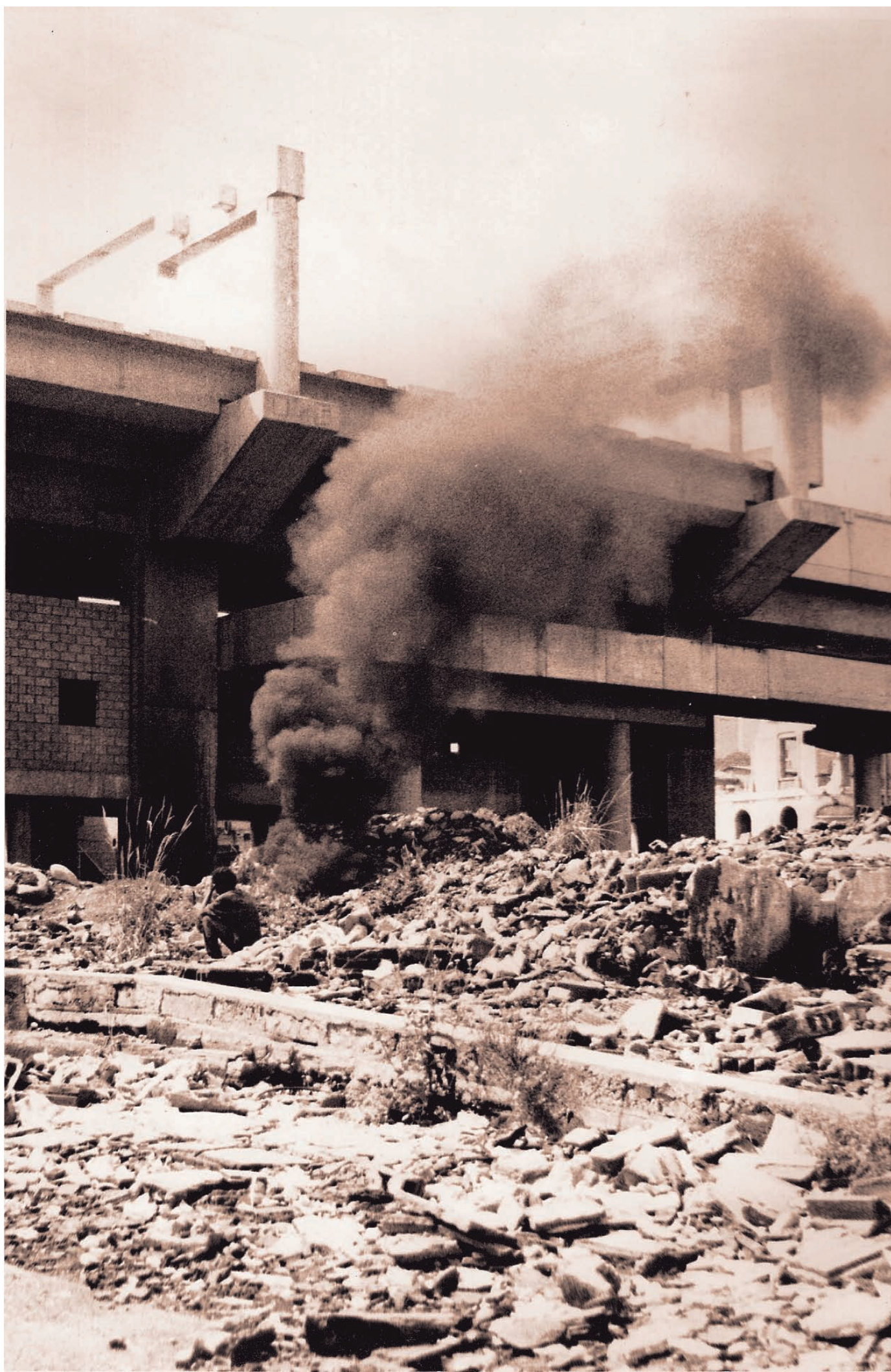
Estación del metro Universidad durante la suspensión de las obras, 1989. Foto: Javier Mejía.
